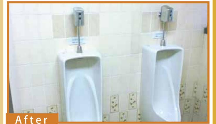
LIXIL製ではない小便器のセンサー故障で洗浄水が流れない状態でした。部品廃番で修理できず、トイレ交換工事をしてくれる知り合いの業者様を探されている時に、LIXILトータルサービスへ相談いただきました。タイルに埋め込まれているセンサーでしたので、新しいセンサーを付けるにはタイルを割って中の給水管を位置替える必要がありました。また当時のタイルが廃番になっていたため、類似色の現行タイルで仕上げる必要がありました。センサーだけでなく小便器本体も一緒に交換させていただき、無事に納めることができました。今後もお客様のお困りの点をお聞きし、一緒に解決させていただきたいと思っております。
