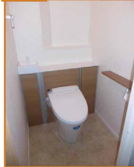
壁が変形に飛び出しており、その壁によって少し狭さを感じてしまうトイレでした。選ばれるトイレによっては、ドアまでの距離が近くなりすぎてしまうという以前からお悩みだったそうです。そこで、飛び出した壁に合わせ新たに壁を造作して棚を作り、その手前に掃除道具などを収納できるキャビネット付トイレのリフォレを設置しました。新設壁を低くしたことで圧迫感もなくすっきりとしたトイレ空間になりました。
